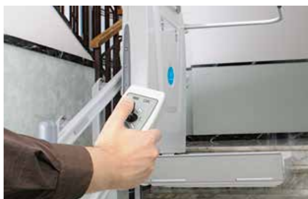
Radiocomando per accompagnatore per pilotare esternamente gli spostamenti, e scatola di chiamata posizionata ai piani
